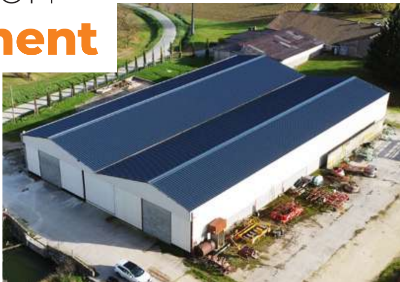
En 2026, le bâtiment agricole racheté, agrandi et rénové sera équipé de panneaux photovoltaïques sur la toiture.
